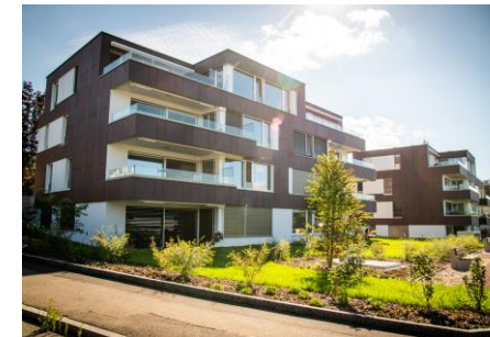
Zero Energy Building, Männedorf 零能耗建筑, Männedorf © Stiftung Umweltarena Schweiz: bit.ly/3f9GbQ9
