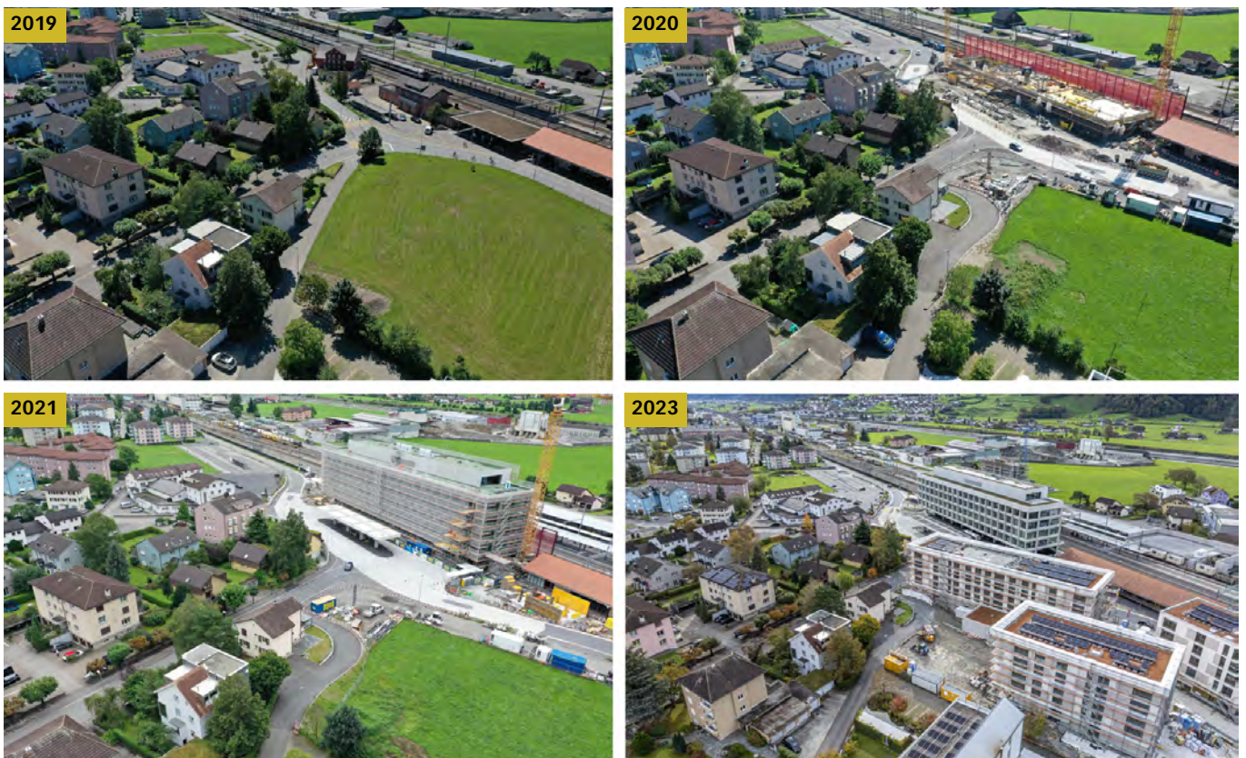
Bild 15: Entwicklung Bahnhofumfeld Altdorf 2019–2023. (Quelle: ARE, Bildmonitoring)
