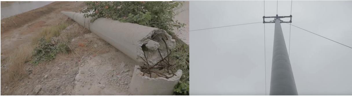
Abbildung 29: Konventionellen versus stabile Strommasten aus Verbundstoffen der BASF
