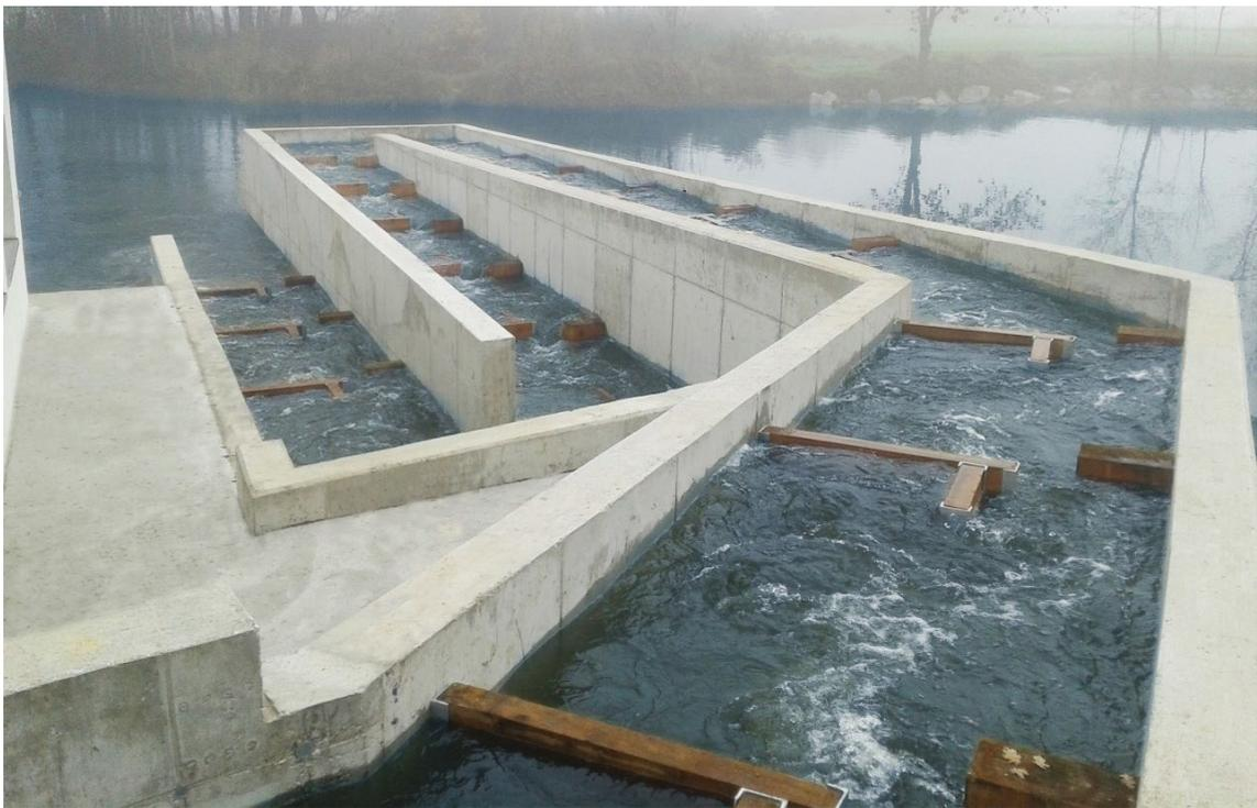
**Abbildung 4** Beispiele einer naturnah gestalteten Fischaufstiegshilfe (oben) und eines Beckenpasses (unten)
