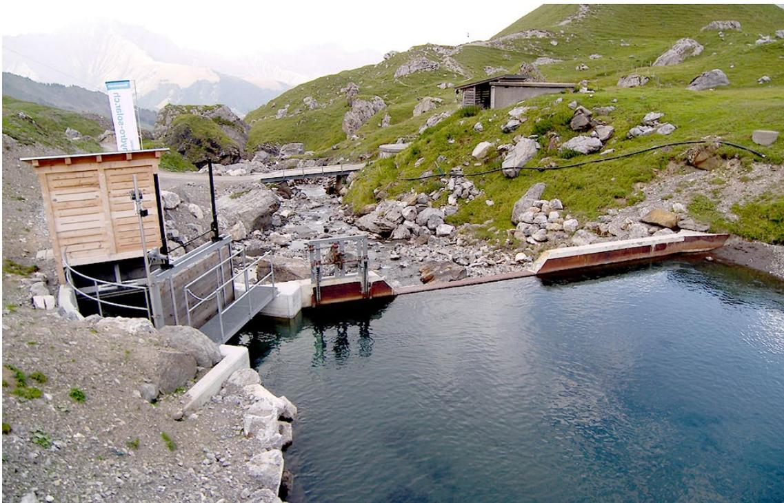
**Abbildung 5** Die von der alten Anlage verbliebene Wehrmauer und die Rechenreinigungsanlage links im Bild
