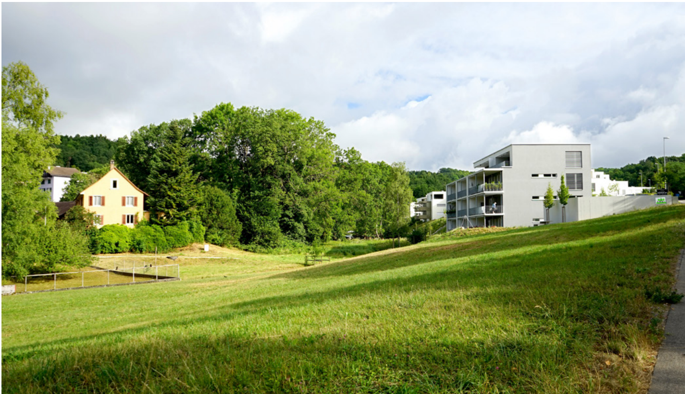
Abbildung 1 – Das noch ländliche geprägte Ortsbild von Herbligen (Schaffhausen) erfordert einen behutsamen Umgang bei einer Innenentwicklung
