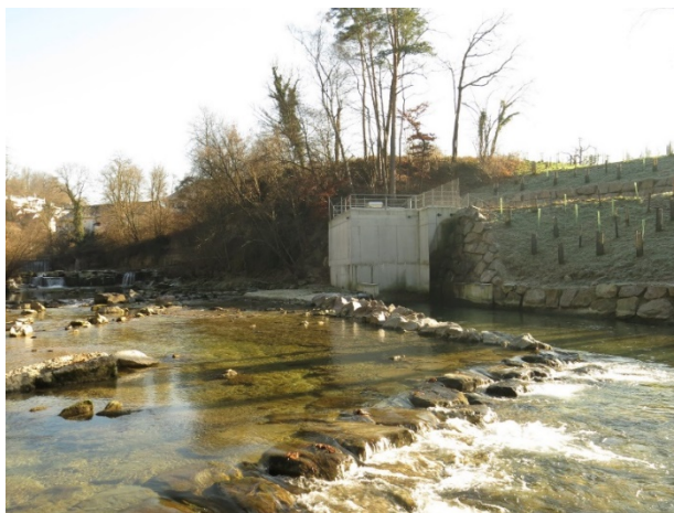
Kraftwerksgebäude mit Unterwasserkanal
