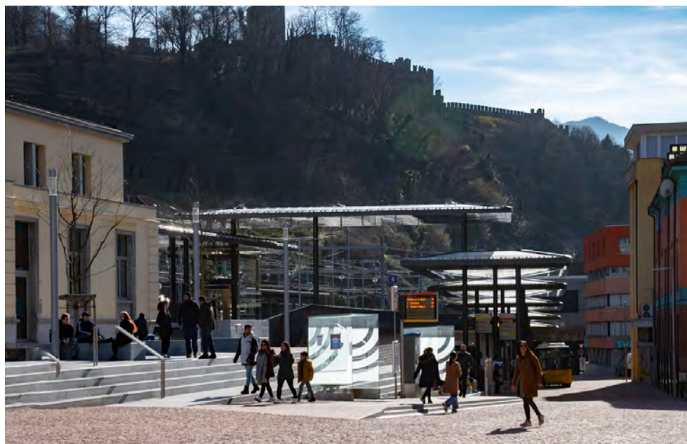
Figure 11: Nouvelle interface multimodale à la gare de Bellinzone. (Source: Sertus Image)
